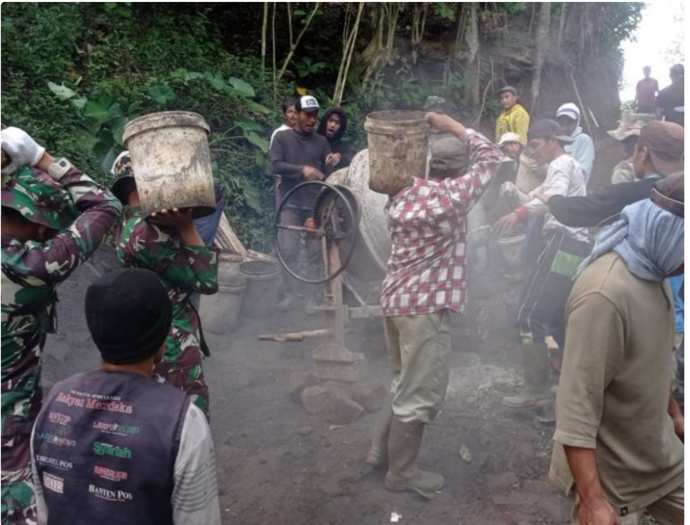
Pelansiran Matrial di Lokasi TMMD
